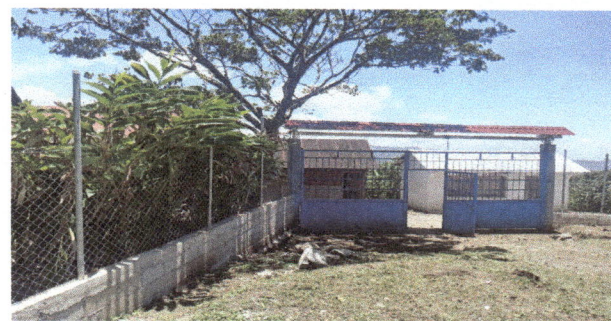
Foto 4: Del muro que se hizo actualmente.
