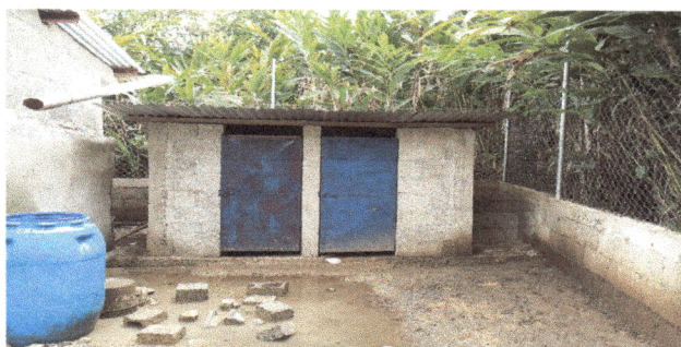
Foto 3: Del baño que se reparo.
